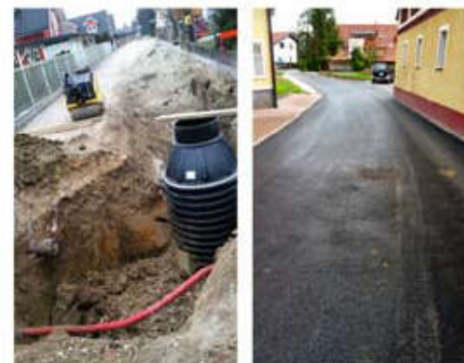
V občini Komenda smo izgradili kanale v skupni dolžini 14.792 metrov.
